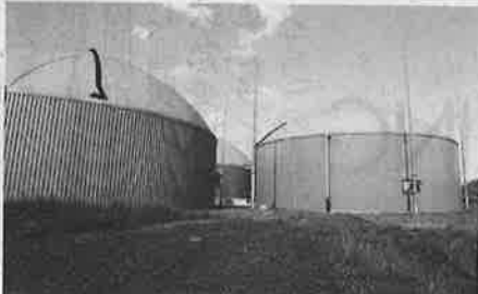
バイオガス発電所
